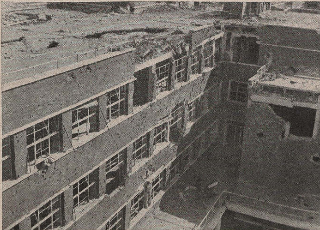
Detalle de los daños sufridos por el edificio.
