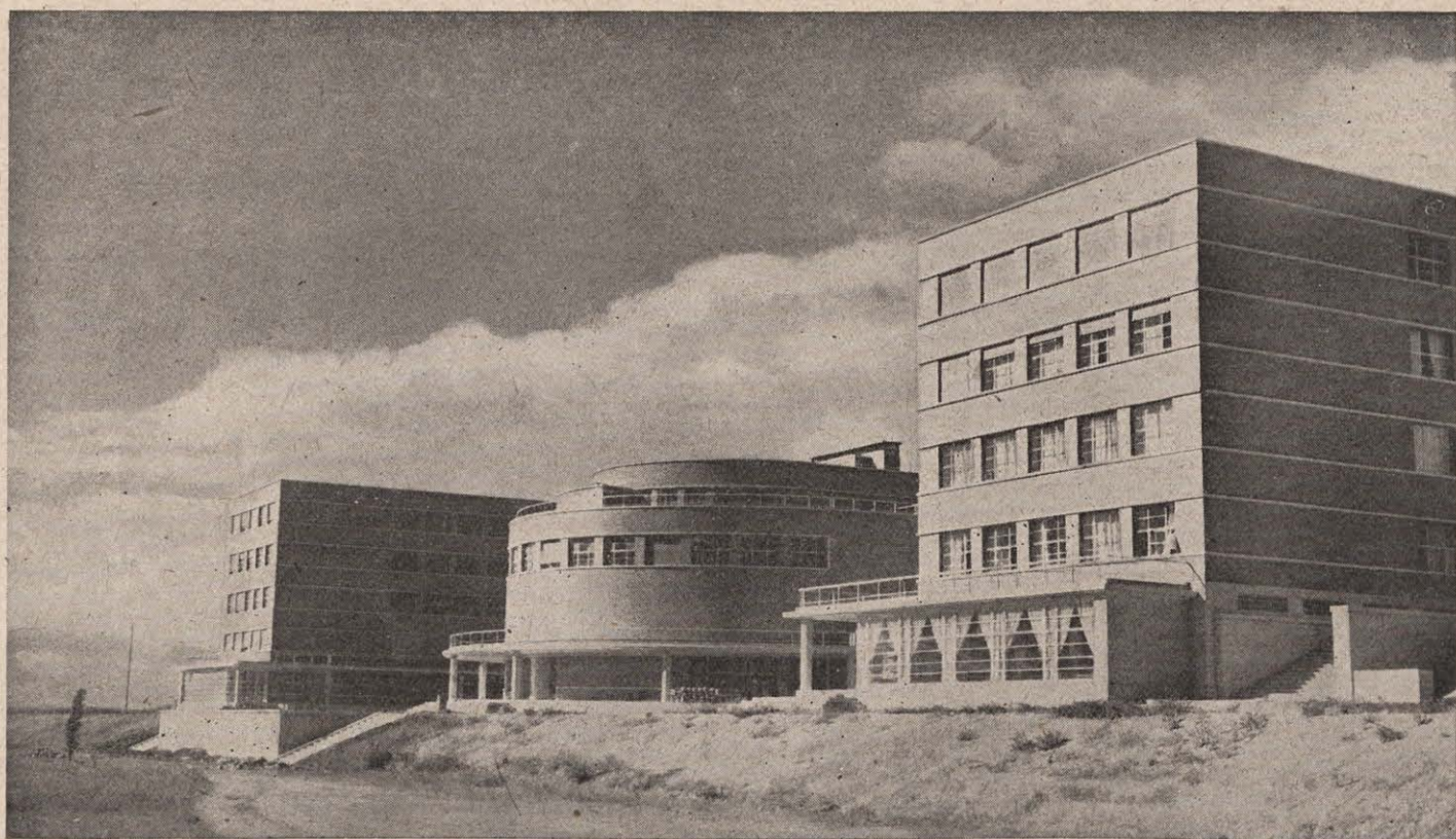
La Facultad de Filosofía y Letras fué terminada en julio de 1936. La guerra produjo grandes destrozos en el edificio, cuya reparación está a punto de ser concluida.
